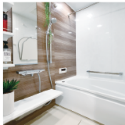
狭かった浴室は構造を確認した上、サイズアップして広いユニットバスに刷新。「どこも明るくて快適です」とT様
