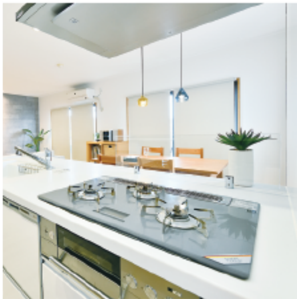
仕切り壁や吊り戸棚を完全撤去。油はねを抑えつつ視野を遮らない透明スクリーンにして、空間に広がり。キッチンがパナソニック「リフォムス」
